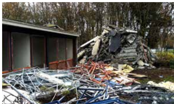
De verschillende materiaalstromen.
